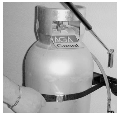
Kontroller at gassflasken er ordentlig festet.
