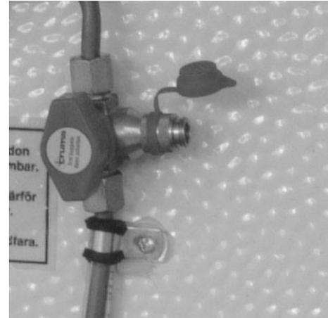
Der Gasdruck des äußeren Anschlusses wird durch das Druckminderventil geregelt und entspricht dem Druck der übrigen Gasanschlüsse im Wohnwagen.
