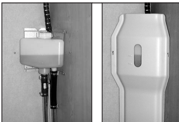
Expansionskärlet och täckskivan med inspektionshål.
