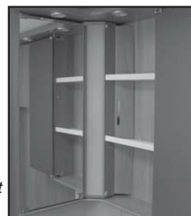
Inspektionshålet placerat i badrumskåpet.
