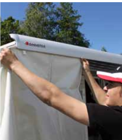
10. Montera fronten i skenan på markisens frontprofil.
