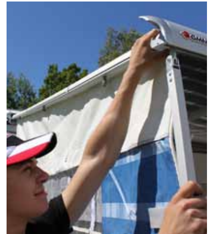
6. Spänn fast överliggaren mellan markisboxen och frontprofilen.
