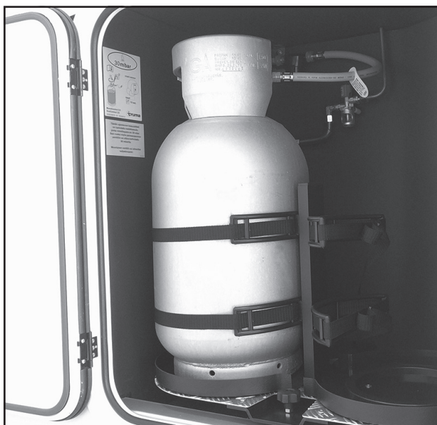
Gasolflaskan i gasolkofferten.
