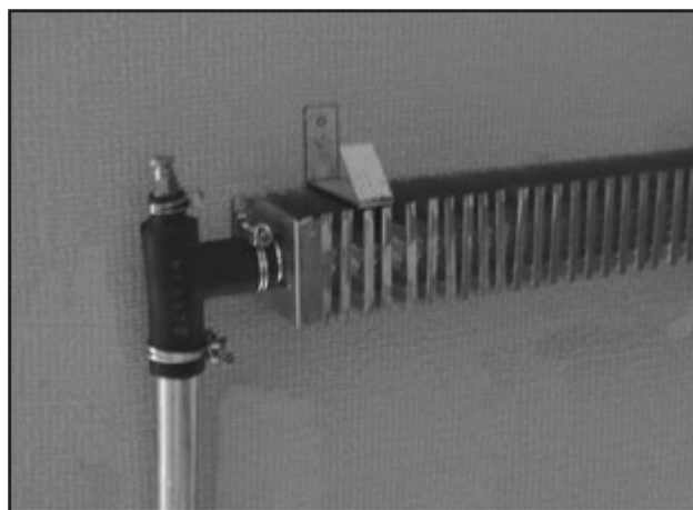
Konvektor och slanganslutning med luftningsnippl.
