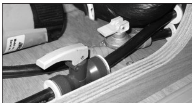
Avtappningskranar för kall- och varmvattenslang.
