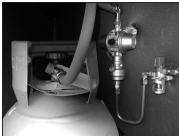
Gasolflaskan i gasolkofferten.
