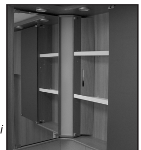
Inspektionshålet placerat i badrumskåpet.
