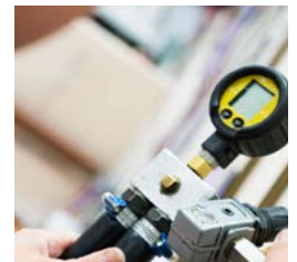
Gasol. Gasolsystemet trycktestas.
