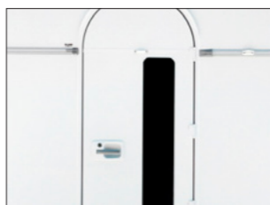
Ytterdörr med tonat fönster
