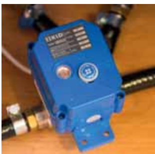
AutoDrain - elektrisk tömning av vattensystemet.
