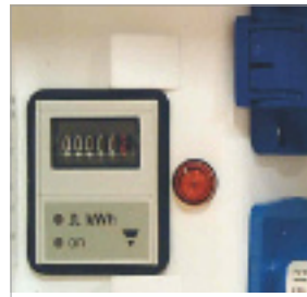
Elmätare Fast monterad i elboxen.
