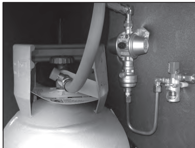
Gasolflaskan i gasolkofferten.
