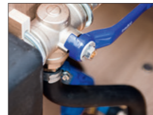
Direktavlopp; förbikoppling grävattentank
