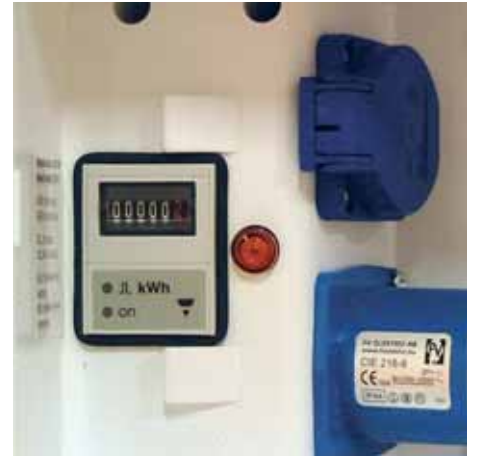
ELMÄTARE ▲ Fast monterad i elboxen.
