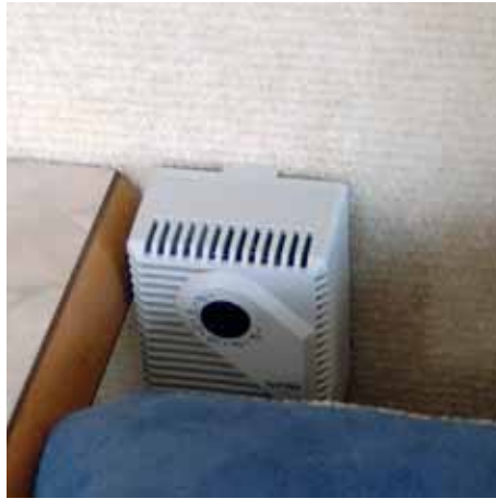
AIRMIXER X0203 ▲ Med sensor. Vid förhöjd luftfuktighet i vagn styrs fläkt av hygrostat. Fläkten kan även styras direkt av strömbrytare.
