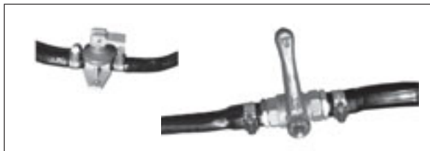
Vattensystemets avtappningsventil för varmvattenberedare respektive avtappningskran för färskvatten.
