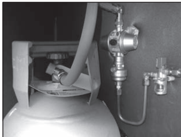
Gasolflaskan i gasolkofferten.
