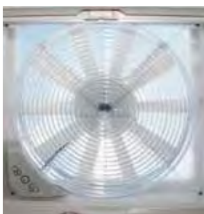
Fläkt med termostat (sovrum) Y0417
